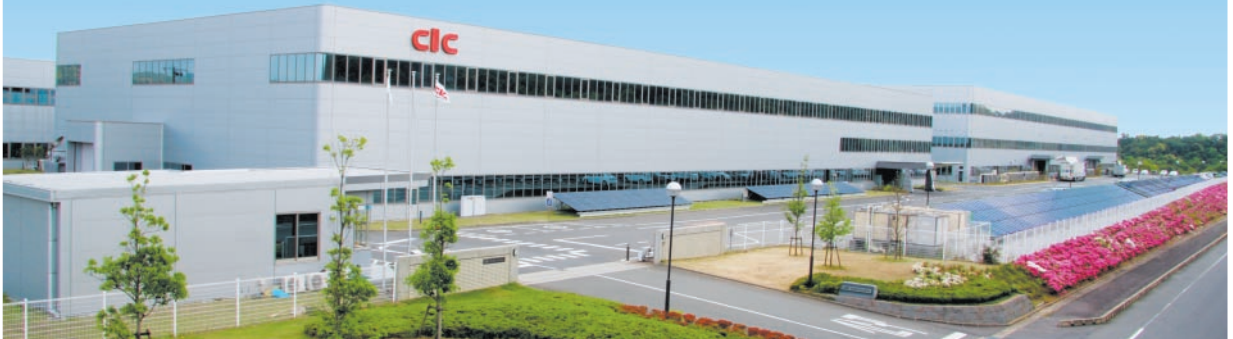
長州産業(株)本社工場 太陽光発電 100kWシステム
